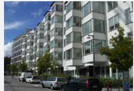
Kv Snickeriet, Hammarby sjöstad. Entreprenör: Veidekke.
