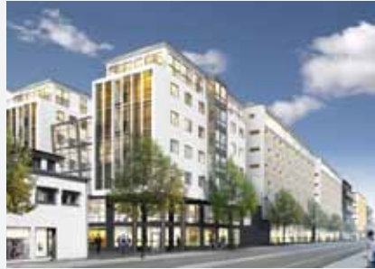
Kv Friggagatan, Göteborg. Entreprenör: Byggfast.
