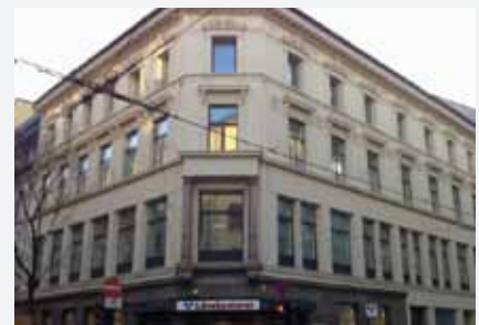
Kirkegatan, Oslo. Entreprenör: REX-bygg AS.
