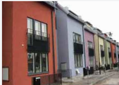
Kv Mursmäckan, Kärrtorp. Entreprenör: Småa.
