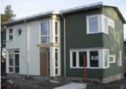
Gruppboende, Hedvigslund. Entreprenör: Småa.
